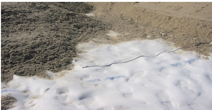
Abbildung 3: Filtrervliesstoff in direktem Kontakt zur Umwelt, auch während der Betriebsphase
