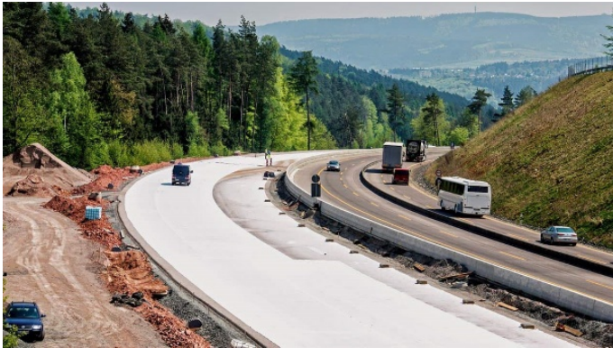
Abbildung 2: Betonstraßentrennvliesstoff, vollständig gekapselt in der Betriebsphase
