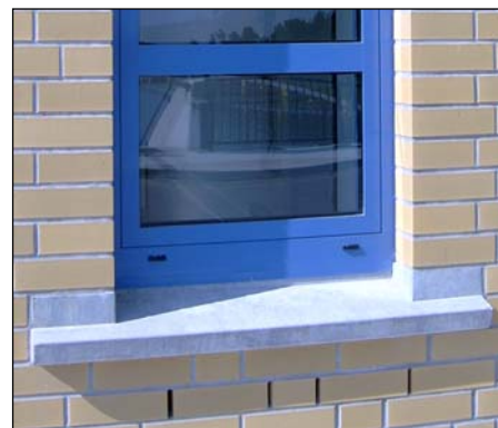
Bild 6/6a: Schleusenanlage Hohenwarthe - Fensterbank -Beton -FT - Entwurf & Ausführung-
