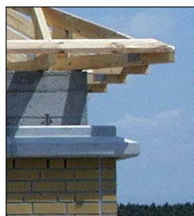
Bild 4/4a : Schleusenanlage Hohenwarthe - Einstiegshaus Betonrähm - Entwurf & Ausführung-
