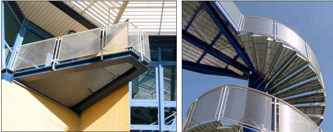
Bild 8: Schleusenanlage Hohenwarthe - Stahlbau für Geländer des SBG –
