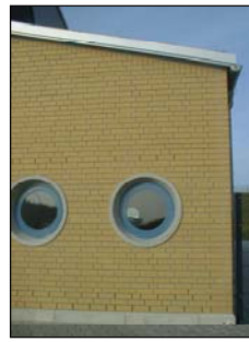
Bild 5/5a: Pumpwerk Hohenwarthe - Sockel und Fensterleibung -Beton -FT - Entwurf & Ausführung-
