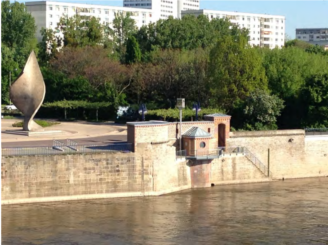
Abbildung 18: Pegel Magdeburg-Strombrücke [Foto: Pohl 2013]
