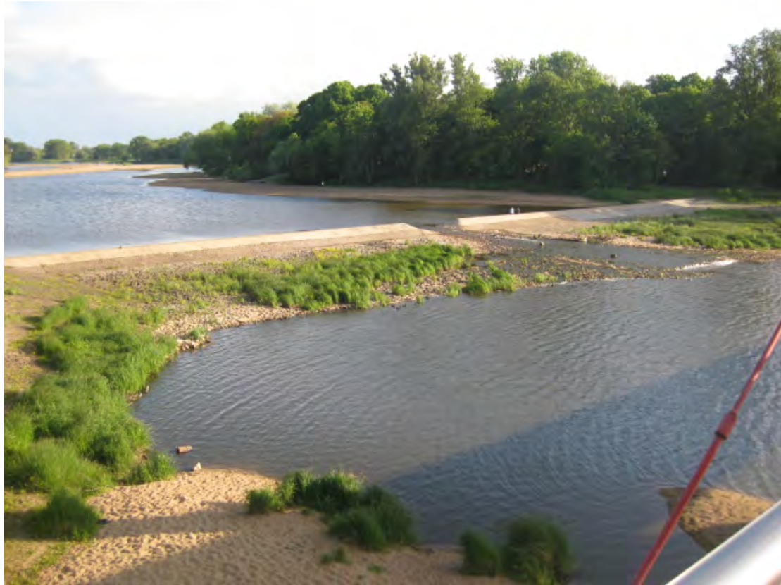
Abbildung 5: Cracauer Wehr (Zustand nach Umbau 1968/69) [Foto: Vietinghoff, 2014]
