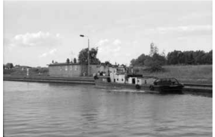
Abb. 6-9: Das ehemalige Barackengebäude an der Ostseite des Oberen Vorhafens zum Schiffshebewerk Magdeburg-Rothensee war bis 1945 Sitz einer Betriebsstelle des Schleppamtes Magdeburg. Danach und während der DDR-Zeit befand sich dort eine Kontrollstelle für die Trans-Schiffahrt. Es wurde nach 1990 abgerissen. (Foto: Dortmund, LWL-Industriemuseum)
