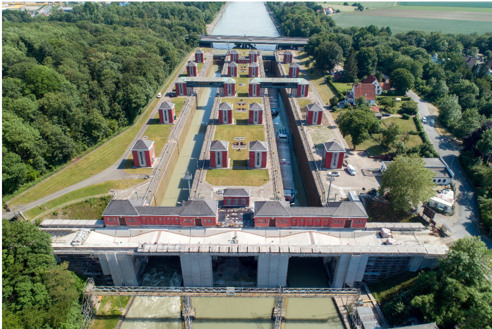
Abbildung 1: Luftbild der Schleuse Anderten in Richtung Oberwasser. Quelle: Historisches Bildarchiv der Bundeswasserstraßen, Archivnummer BB03414
