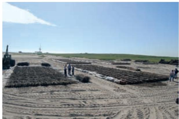
Foto 9: Fertigung Sinkstücke (2009)
