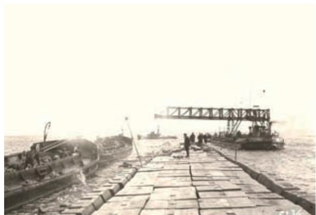
Foto 5: Betonblöcke als Kronenabdeckung, Buhne B (1928)
