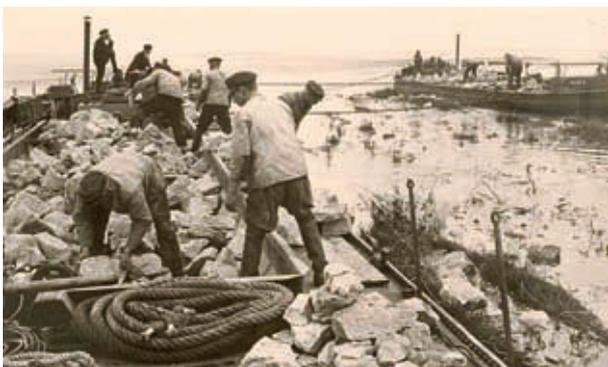
Fotos 6a + b: Einbau Sinkstücke (1936)
