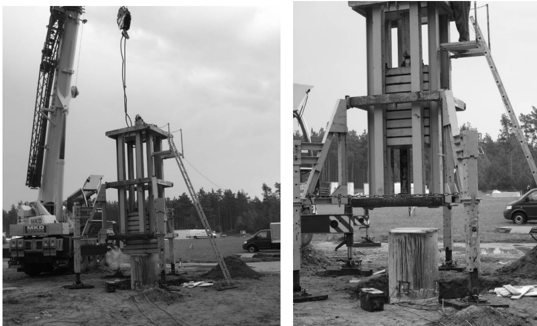
Abb. 8: Dynamische Probelastungen
