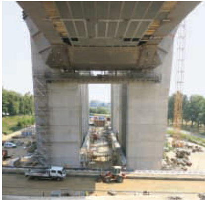
Abb. 14: Baustellenansicht Richtung Osten, Juli 2014 (Quelle: WNA Berlin)
