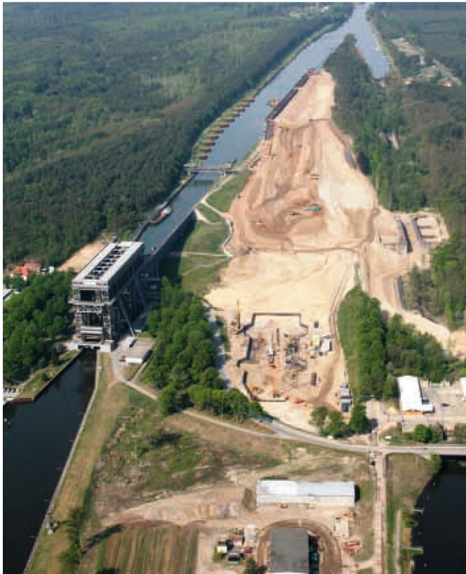
Abb. 11: Luftbild über die gesamte Baufläche, Stand April 2009 (Quelle: WNA Berlin)
