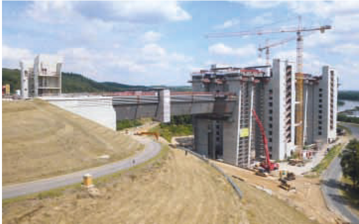
Abb. 13: Hebewerkbaustelle Ende April 2014 (Fotos 12+13: BAW)
