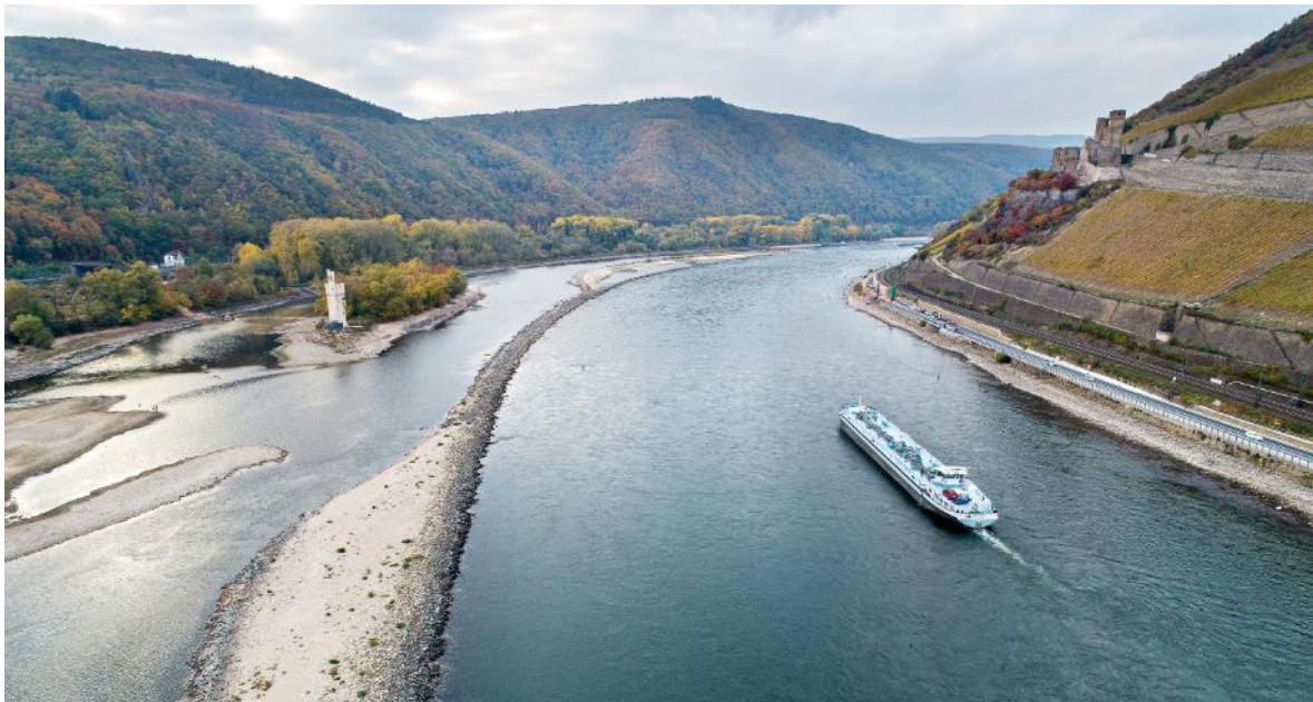
Abb.: Längswerk am Binger Loch (Bildmitte) (Quelle: BAW).
