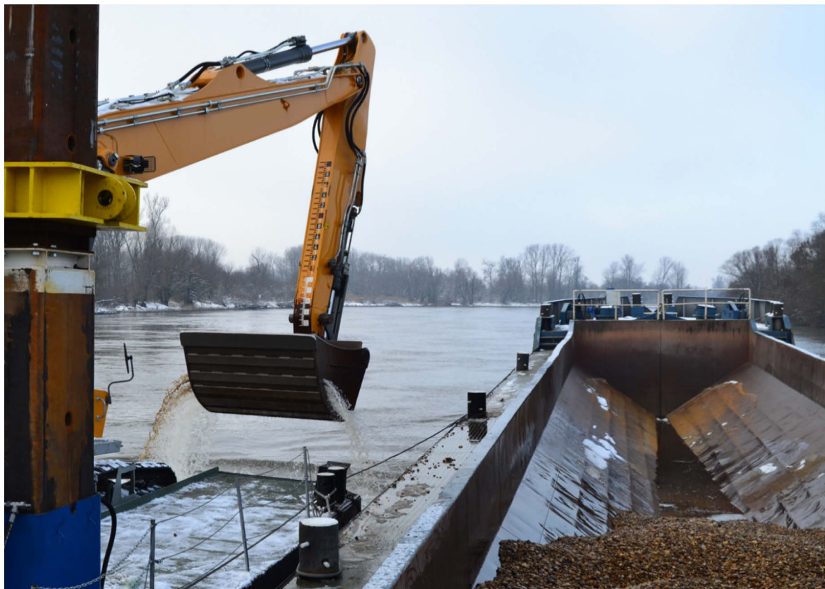
Abb.: Nassbaggerung (Quelle: BAW).
