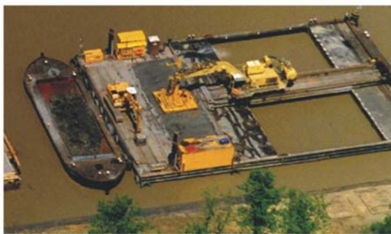
Bild 1: Tonplatten-Verfahren (Fa. Möbius)
