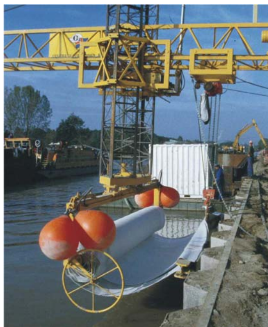
Bild 4: GTD – Verlegung (HOW)
