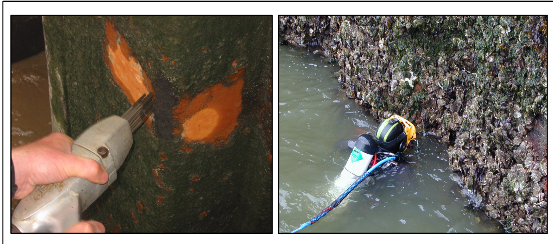
Bild 17: Reinigung von Messstelle von Rost und Bewuchs
