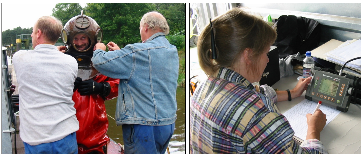
Bild 16: Spundwanddickenmessung: Personal im Wasser und an Land
