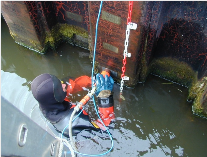
Bild 15: Spundwanddickenmessung mit Messkette
