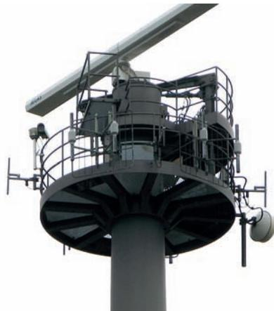
Abb. 3: Radarturm Ritzenbüttel mit UKW-Funkantennen
