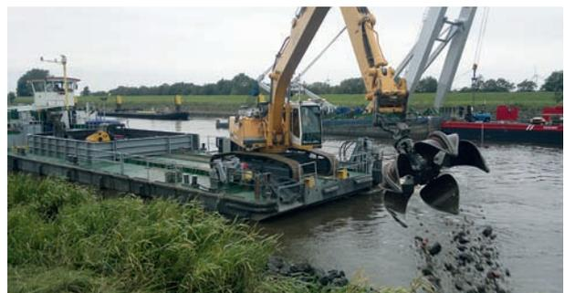
Abb. 13: Instandsetzung Ufer durch HARRIERSAND
