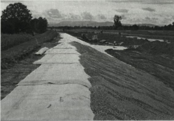
Abbildung 3: Verlegte GTD-Bahnen mit Deckschicht, Sanierung der Kinzigdeiche (Quelle: Ingenieurbüro BBG, Lemförde)
