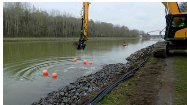
(b) Einbau des neuen Deckwerks
