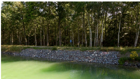
(c) Versuchsstrecke nach dem Einbau
