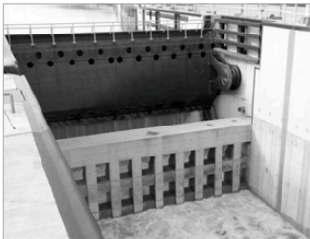
Abb. 2: Standard-Drucksegment im Obertor der Schleuse Bolzum (HEINZELMANN & THORENZ 2014) (Foto: Thorenz, BAW)
