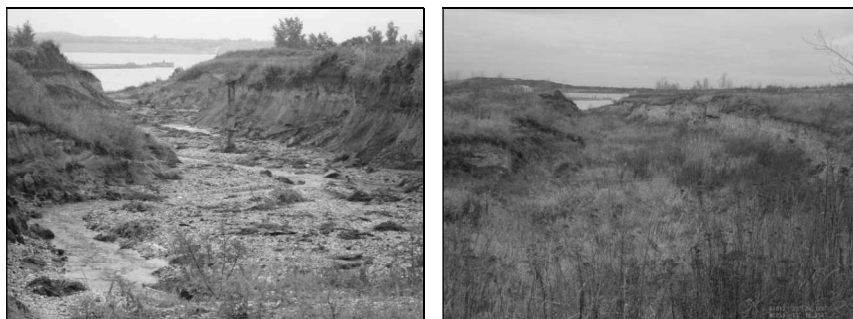
Abbildung 5: Göselcanyon bei abklingender Hochwasserwelle im Juni 2013 (links), ähnliche Blickrichtung im Dezember 2015 (rechts)
