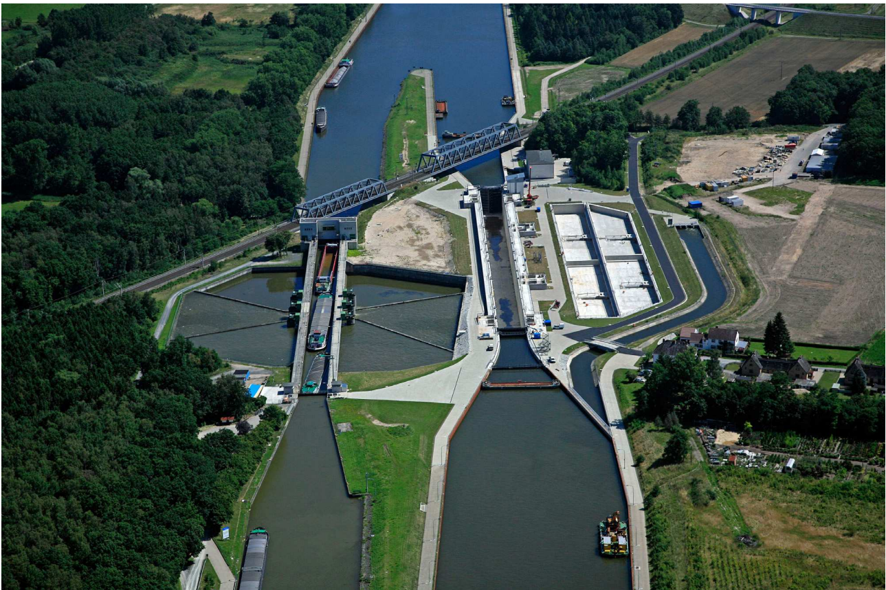
Abb. 1: Schleusenanlage Sülfeld, Nordkammer und neue Südkammer
