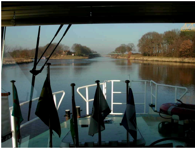
Bild 3: Schleusenkanal Dütthe mit schmaler Brücke
