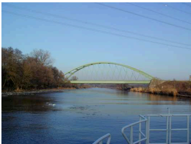
Bild 13: B 402 DEK-Brücke bei km 170
