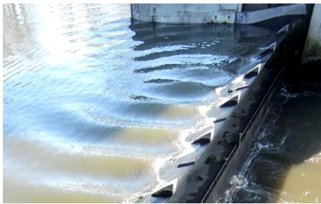
Bild 3: Links: durch Biegeschwingung hervorgerufene stehende Welle im Oberwasser eines Hub-schützes mit Aufsatzklappe. Rechts: Geschwindigkeitsverteilung im abgeleiteten 2D-Modell.
