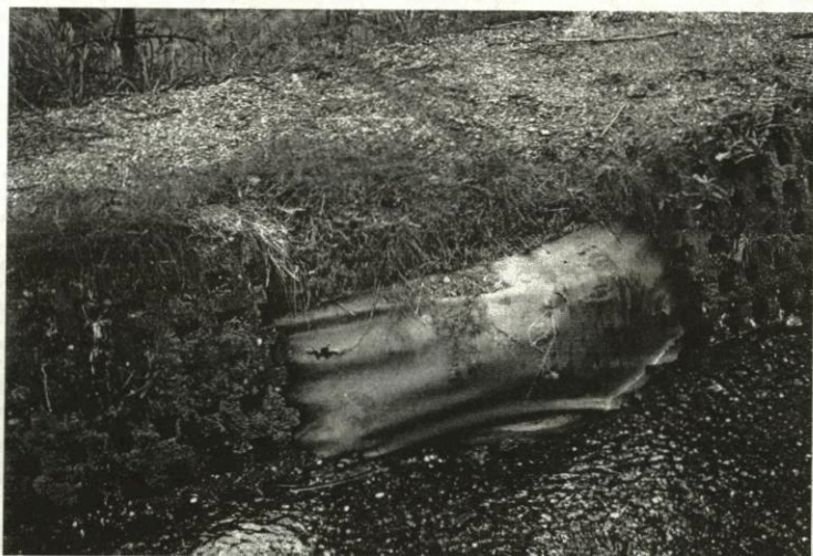
Bild 2: mit Folie gedichteter Hanggraben, Folie über einem Stein
