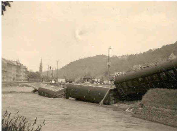
Abbildung 9: Bahnhof Meissen-Triebischtal nach dem Hochwasser 1941 (Foto vom Landratsamt Meissen, Untere Wasserbehörde freundlicherweise zur Verfügung gestellt)
