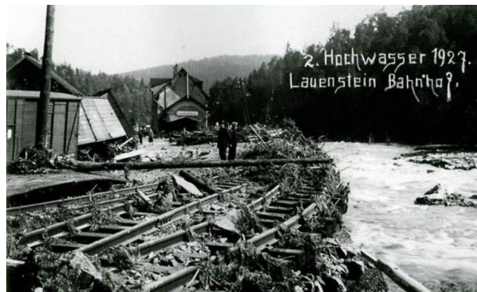
Abbildung 6: Abbildung 1: Bahnhof Lauenstein nach dem Hochwasser 1927
