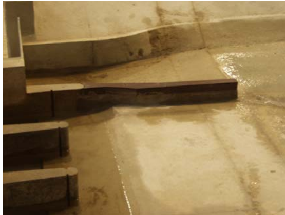
Abbildung 7: Trennpfeiler 1, Verlängerung auf volle Höhe
