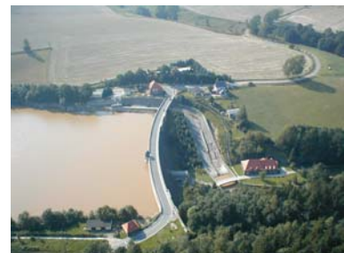
Abbildung 3: Mauer- und Seesicht nach Ablauf des Hochwassers 2002
