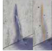
Abstoppen von drückendem oder fließendem Wasser in Rissen und Hohlräumen.
