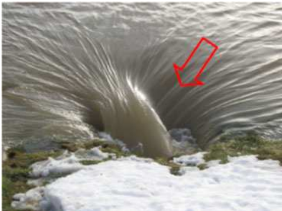
Abbildung 2: links: verstärkte Strudelbildung wasserseitig; rechts: Dammbbruch
