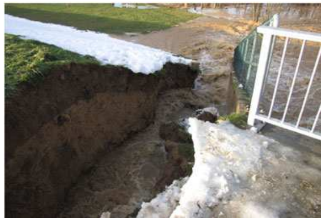
Abbildung 2: links: verstärkte Strudelbildung wasserseitig; rechts: Dammbbruch
