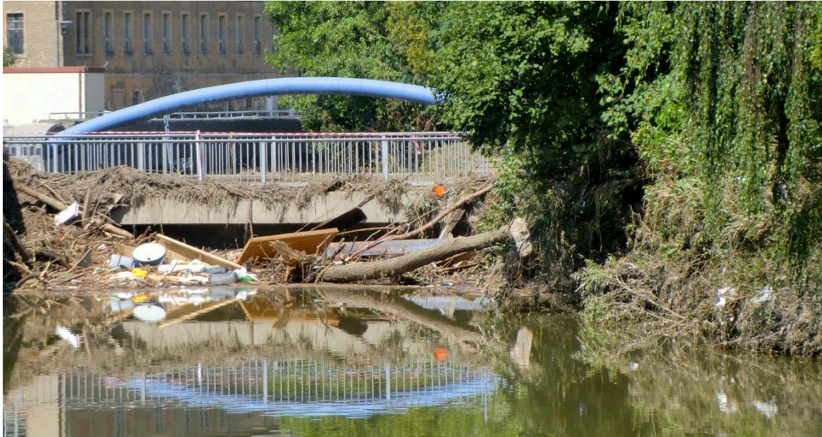
Abbildung 2: Verklausung der Brücke Bahnhofstraße in Ostritz (Foto: LTV)
