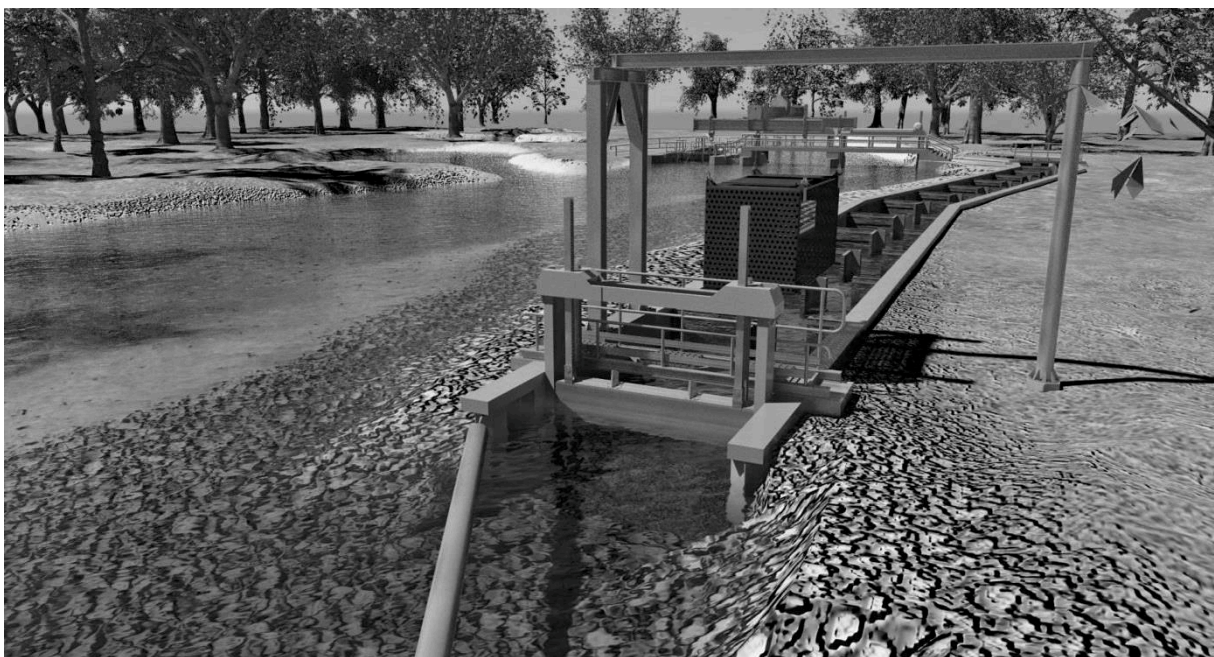
Abbildung 8: Reusenfanganlage mit Portalkran innerhalb des in Abbildung 1 dargestellten Schlitzpasses (Visualisierung Lohmann und Robinski GbR).
