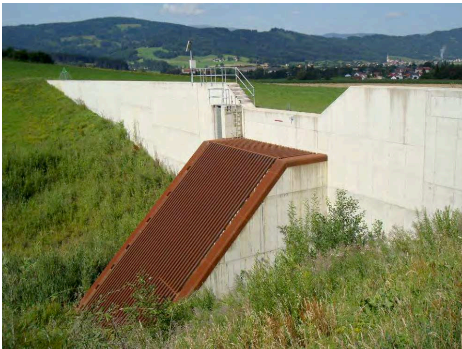
Abbildung 3: RHB Mittergrabenbach, Instrumentierung und Begehungssteg
