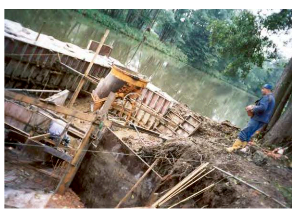
Abbildung 2: Herstellung Wartungstreppe Sensorbauwerk 1 (beide Abb.: BFUL 2014 )
