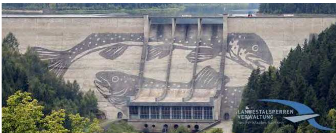
Abbildung 1: Talsperre Eibenstock (Foto: LTV)
