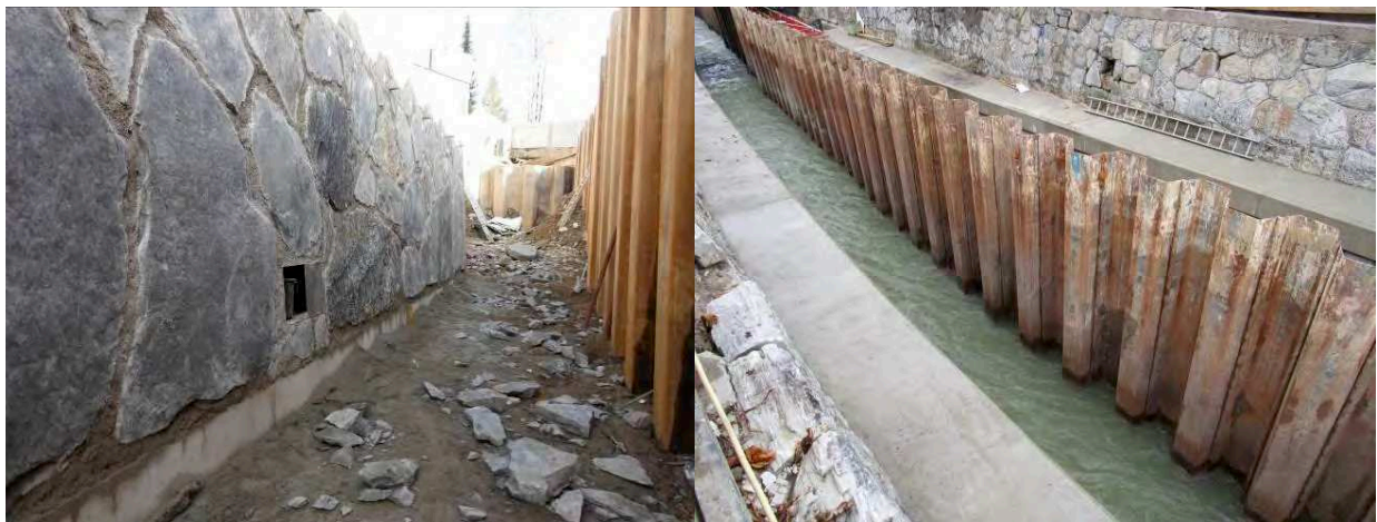
Abbildung 4: Fertiggestellte Pflasterung mit glatten Steinen(links), Spundwände (rechts)
