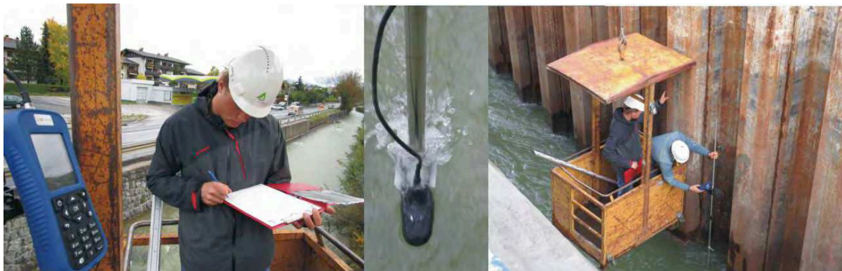
Abbildung 6: Fließgeschwindigkeits- und Abflussmessung mit dem MF-PRO [Ott]
