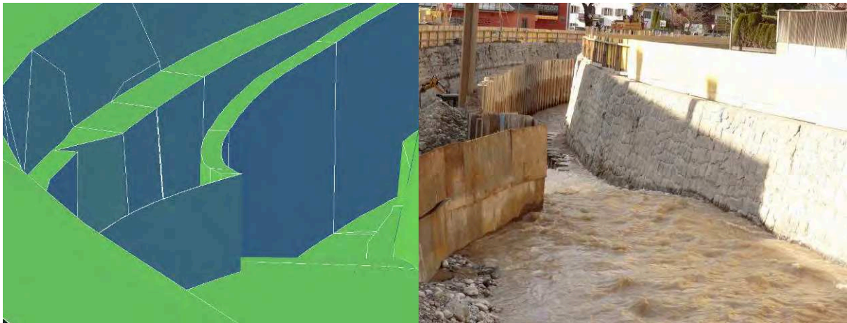
Abbildung 2: 3D Modell des Einlauftrichters (links), Spundwand mit Wasserhaltung (rechts)
