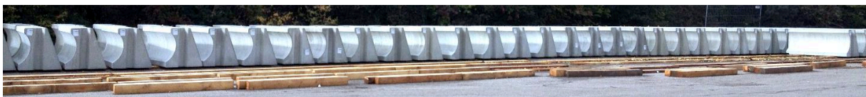
Abbildung 3: Zwischenlager der Wellenumlenker (Nr. 12 in Abb. 4) vor dem Einbau am Oberbecken des PSW Säckingen (Eggbergbecken). Bildquelle: Pohl
