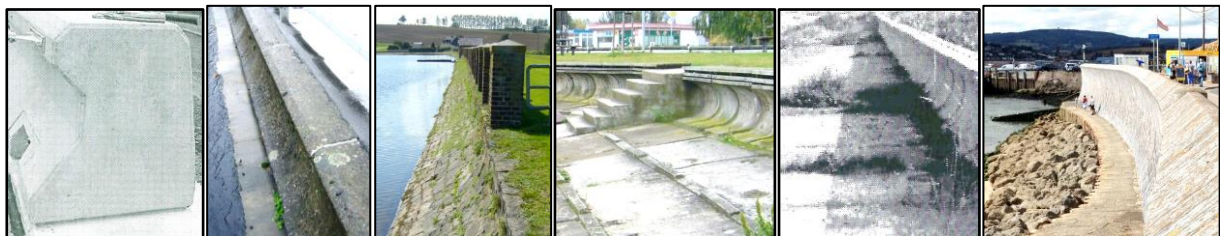
Abbildung 2: Ausführungsbeispiele für Wellenumlenker (v. l. n. r.) 1. als Polygon ausgebildeter Wellenumlenker auf der Krone der Talsperre Bautzen (Nr. 3 in Abb. 4), 2. in den Dammkörper eingelassener Umlenker an der Talsperre Nonnweiler (Nr. 13 in Abb. 4), 3. Ausgerundete Wasserseite mit aufgesetzter Wellenschutzmauer auf dem Dammbes des oberen Großhartmannsdorfer Teiches der Revierwasserlaufanstalt Freiberg, 4. Raudeckwerk und Wellenumlenker an der Ostseite des Süßen Sees bei Eisleben, 5. Asphalttrauhdeckwerk und Wellenumlenker südlich von Dranske (Rügen), 6. Ausgerundete Ufermauer in Exmouth, Devonshire (GB). Bildquelle: Pohl
