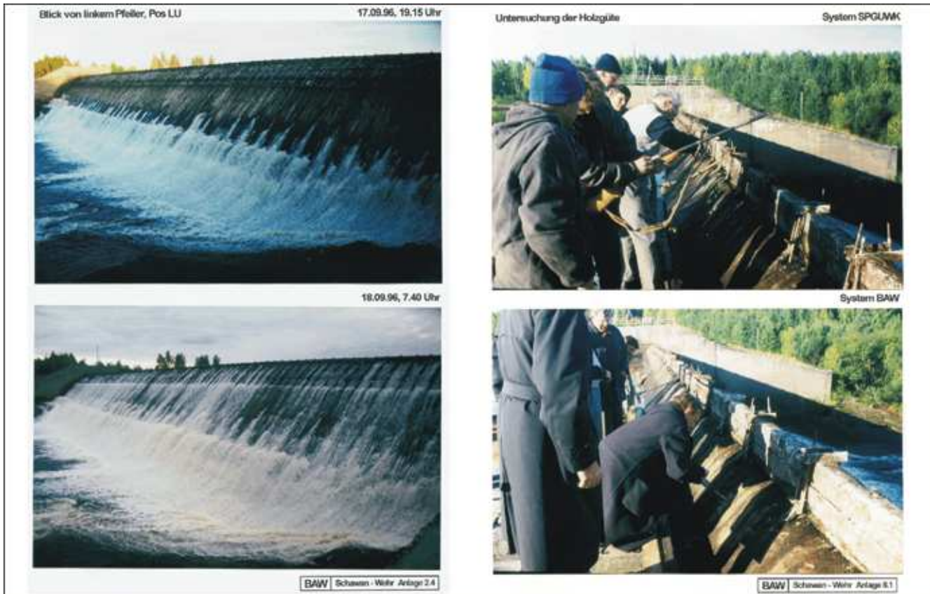
Bild 3: Durchströmung des Schwanen-Wehres (Abstau, Wiederaufstau) und Güteprüfung des Holzbaustoffs
