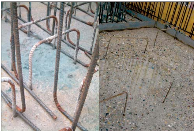
Bild 7.2: Nicht vorbereitete (Bild links) bzw. fachgerecht vorbereitete Arbeitsfugenflächen (Bild rechts)
