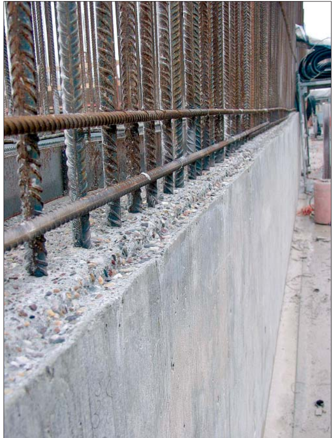
Bild 7.3 Arbeitsfuge nach Entfernen der Begrenzung (Dachlatte) und Vorbehandlung
