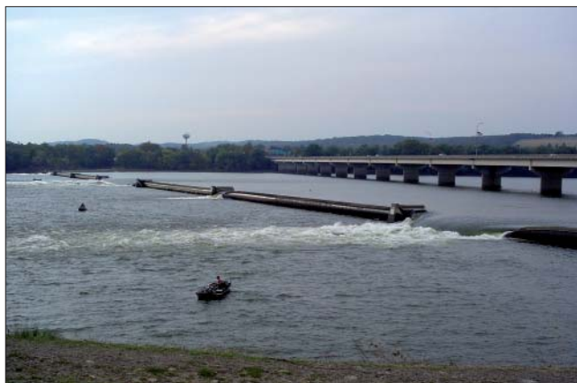
Bild 2: Sunbury Dam mit teilweise abgelegten Schlauchwehren [7]
