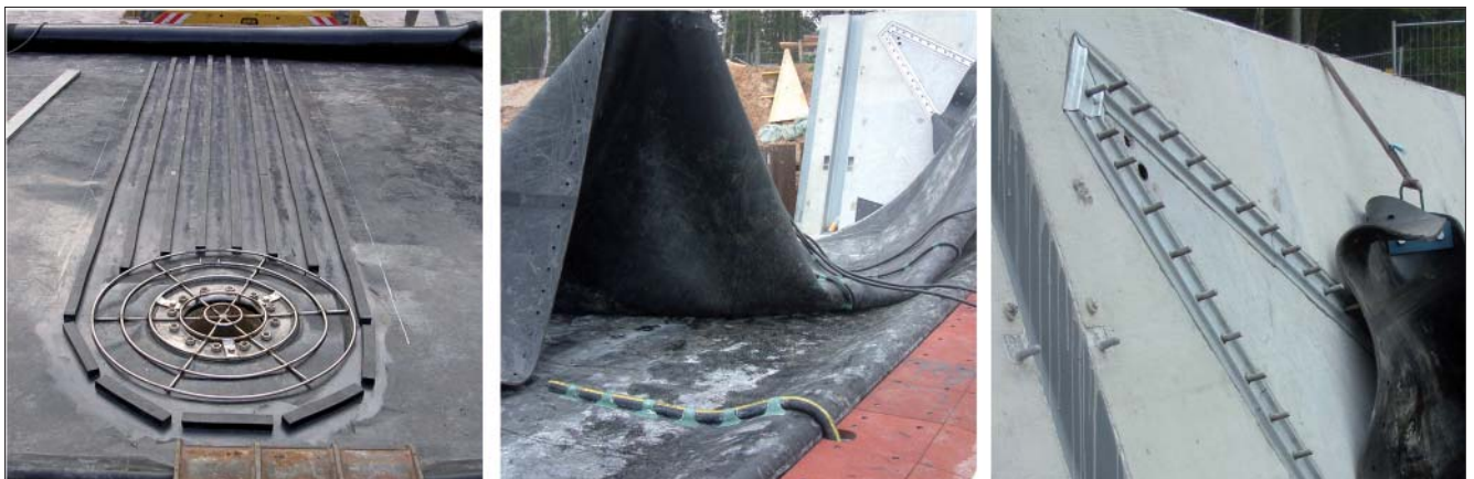
Bild 6: links: Sickerplatten [12]; Mitte: Entleerungsleitungen; rechts: seitliche Entlüftungsöffnungen im Wehrpfeiler
