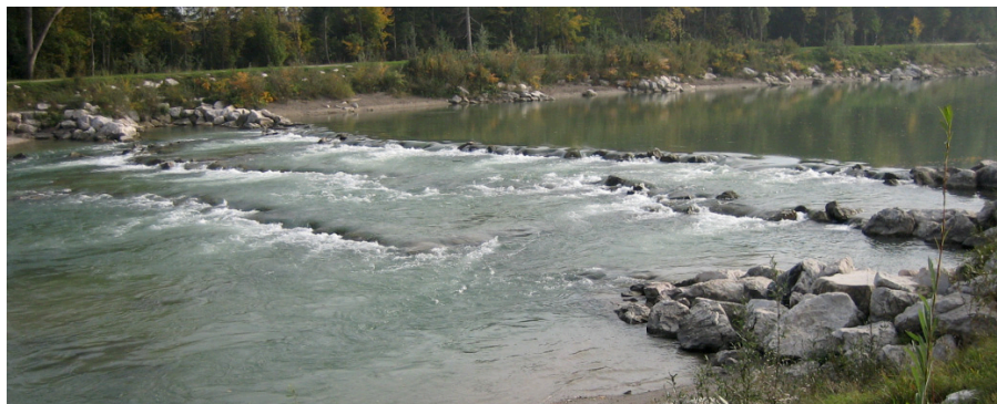
Abb. 1: Rampe an der Saalach ca. 2,5 Jahre nach Fertigstellung (Foto: Bundesamt für Wasserwirtschaft)
