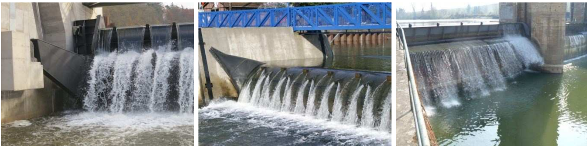
Bild 1: Beispiele für Wehrüberfall mit geringem Wasserpolster im Unterwasser bzw. auf dem Verschlusskörper
