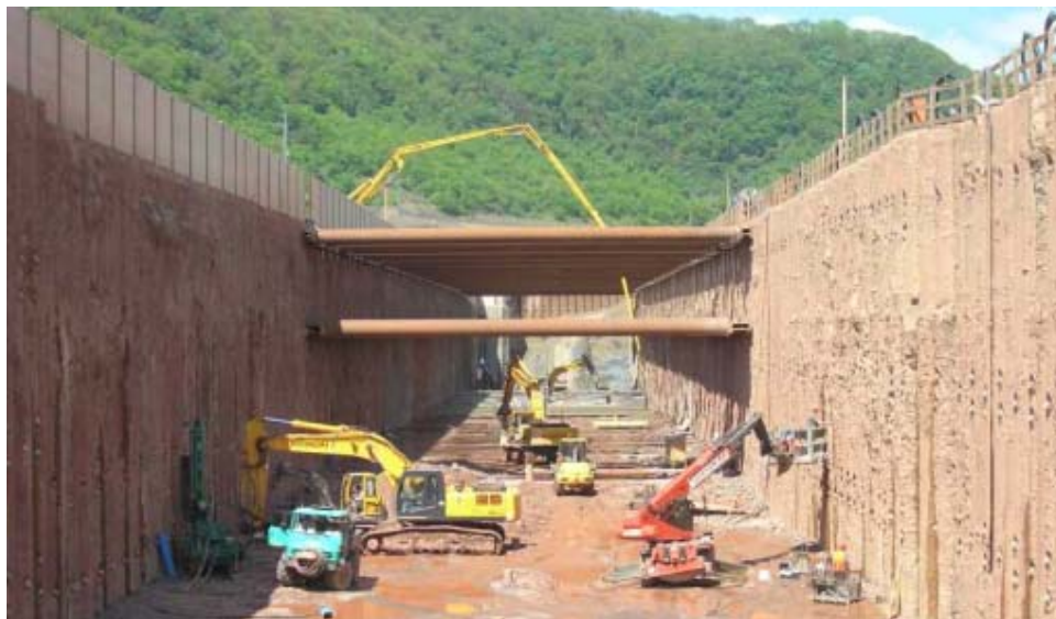
Bild 7: Baugrube Schleuse Fankel mit Aussteifungen der Borpfahlwand oberhalb der Seiteneinläufe
