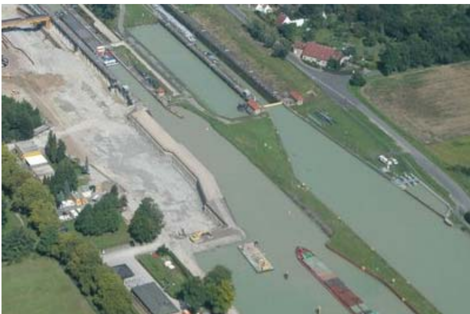
Bild 9: Böschung und Fangedamm zur Sicherung der Baugrube gegen Schiffsstoß
