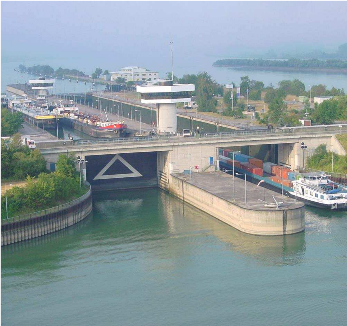
Bild 1: Schleusenanlage Iffezheim mit Brücke B 500
