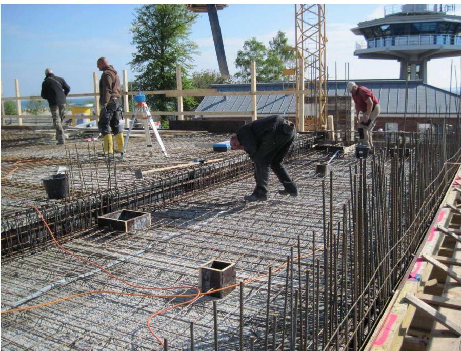
Abb. Bewehrung der Obergeschossdecke
