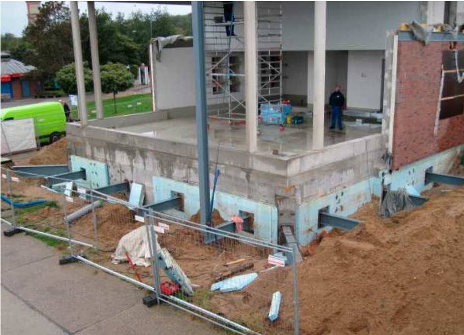
Abb. Kragarme mit der ersten Stütze
