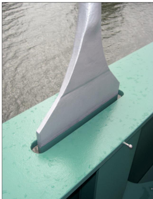
Bild 1: Geschmiedeter Hängeranschluss
