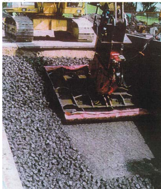
Bild 3: Tonwürfel-Verfahren (Fa. L. Freytag)
