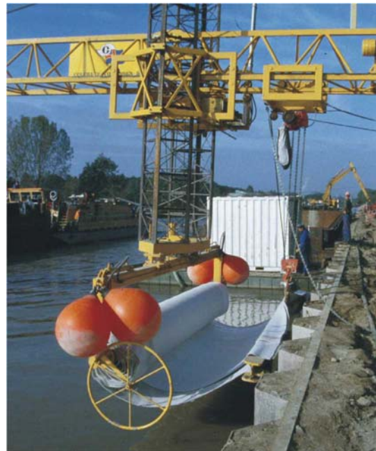
Bild 4: GTD – Verlegung (HOW)
