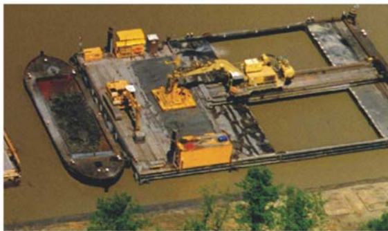
Bild 1: Tonplatten-Verfahren (Fa. Möbius)
