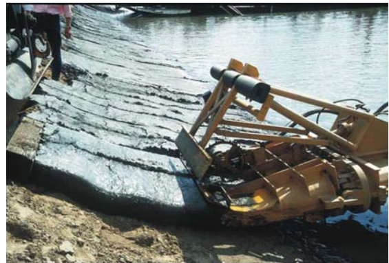
Bild 2: Tonbahnen-Verfahren (Fa. Bunte)
