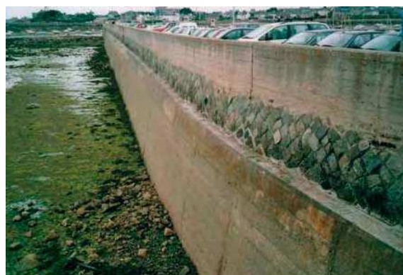
b. Sanierung mit Ortbetonwand
