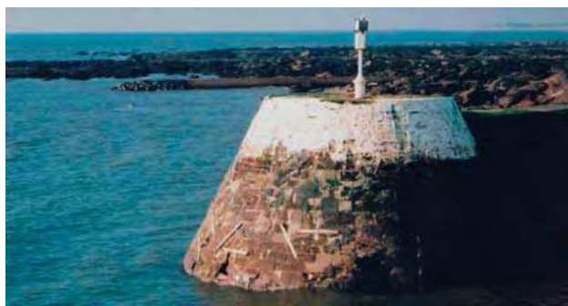
a. Leuchtturmmole Abroath West Breakwater
