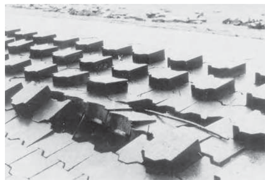
b. Schäden an einem Deckwerk
