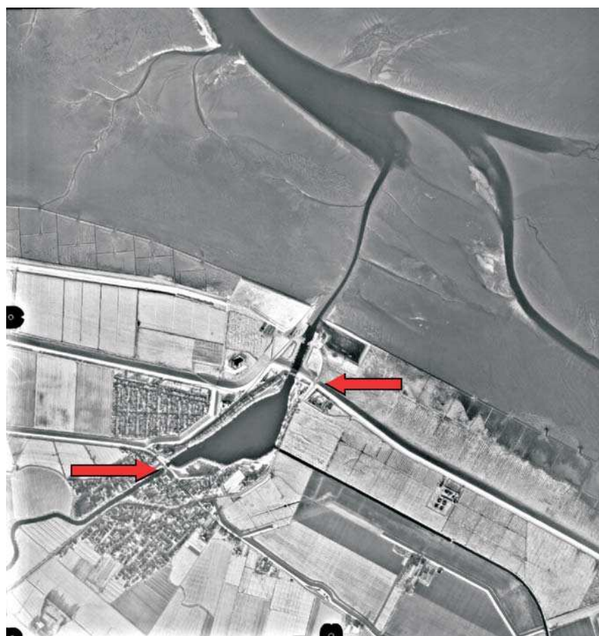
Abb. 2: Sielbecken Accumersiel. Mit roten Pfeilen markiert sind die wichtigsten Zuflüsse zum Sielbecken
