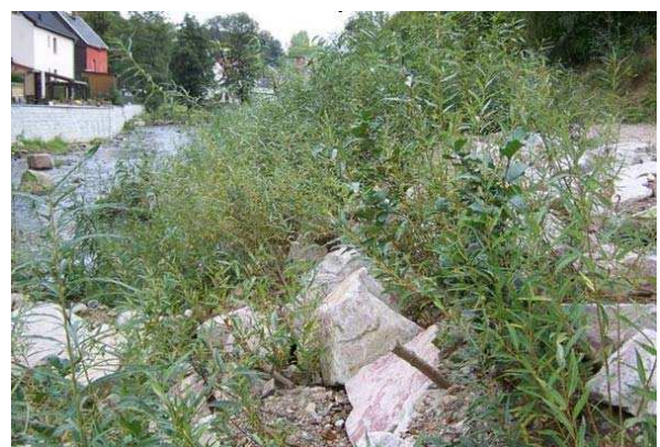
Bild 7: Mit Steckhölzern begrünte Steinschüttung
