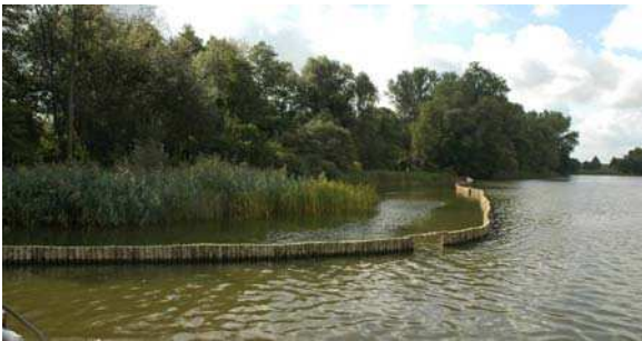
Bild 8: Pfahlreihe im Bereich der Unteren Havel-Wasserstraße
