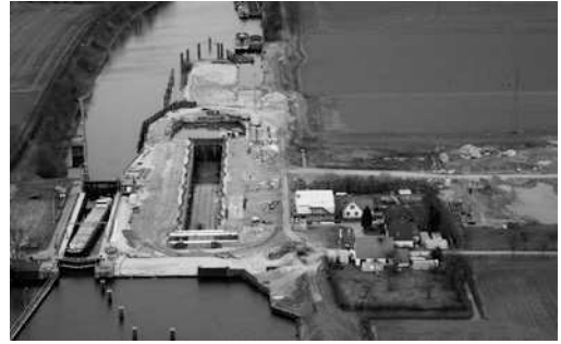
Bild 4: Luftbild vom Baufeld
