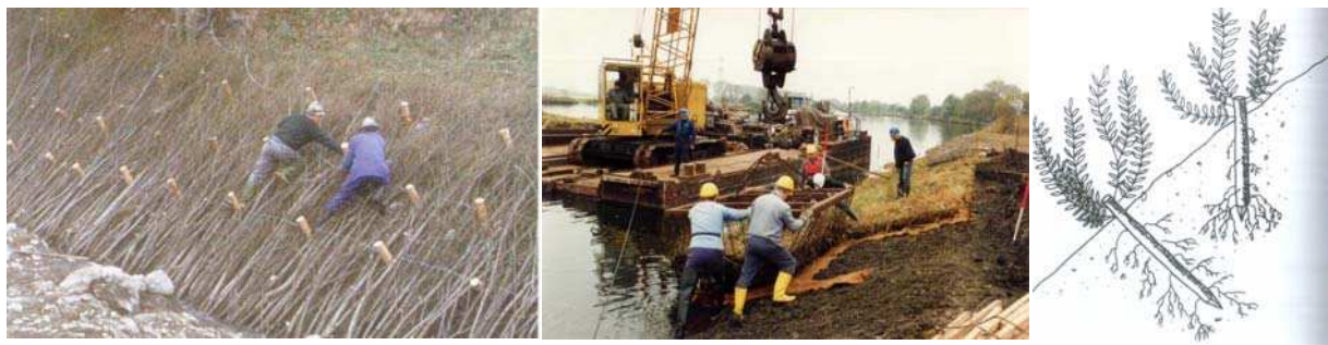
Abb. 5: Biologische Ufersicherungen, links: Spreitlagen, Mitte: Vegetationsmatten, rechts: Steckhölzer (Fotos: BAW/BfG)
