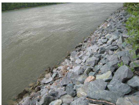
Abb. 2: Mit Schüttsteinen gesichertes Ufer am Rhein, das überwiegend frei von pflanzlichem Bewuchs ist (Foto: Eisenmann, BAW)
