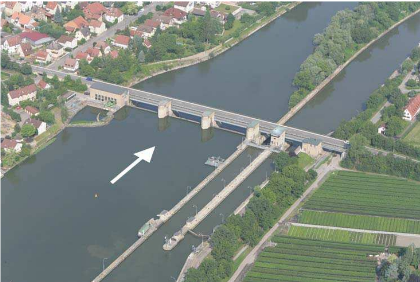
Bild 1: Staustufe Lauffen, Blick vom Oberwasser: links das Kraftwerk, in der Mitte das Wehr, rechts die Schleusenanlage (Quelle: Amt für den Neckarausbau Heidelberg).
