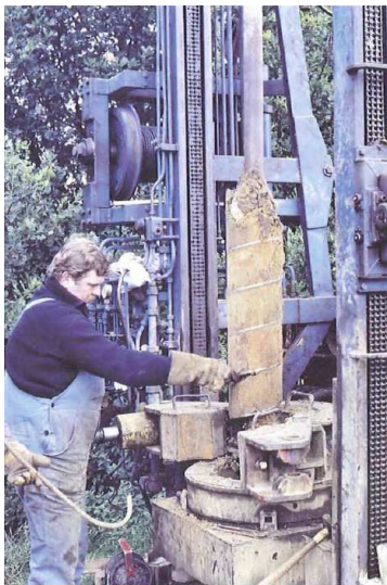
Bild 4: Schneckenbohrung zur Baugrunderkundung.
