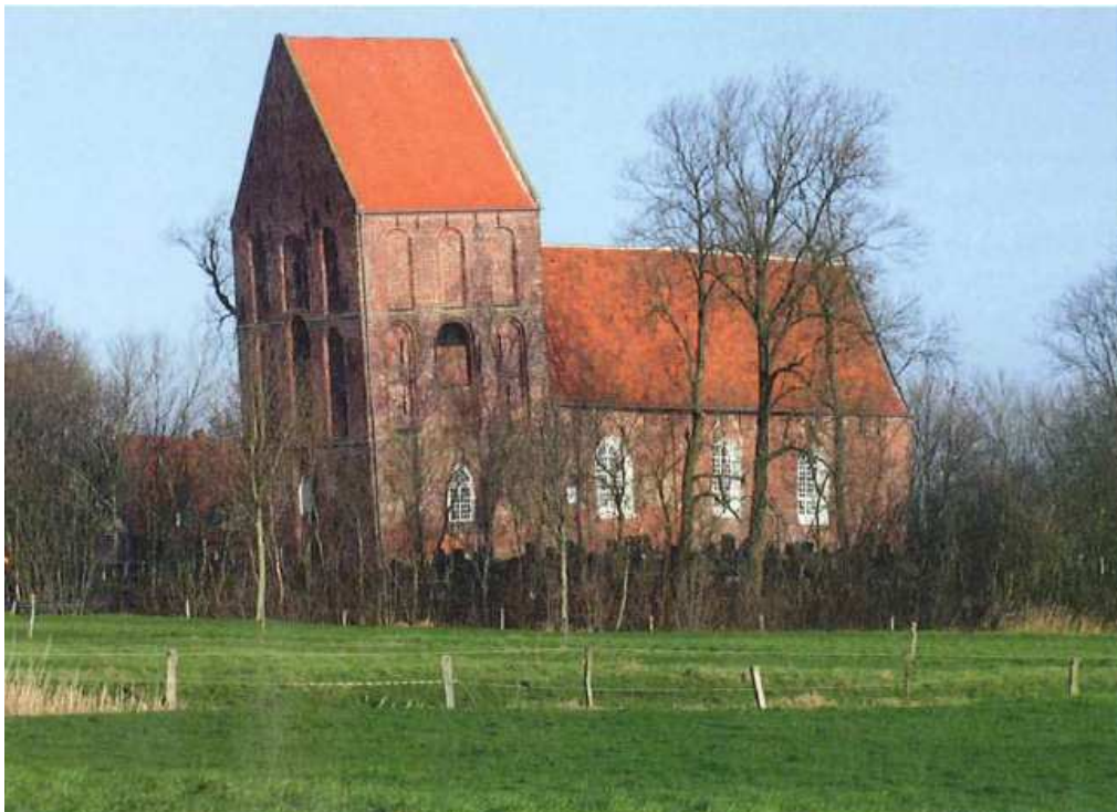
Abb. 1: Wenn man den Baugrund nicht kennt, kann sich in einigen Jahren oder noch später einiges Unvorhergesehenes ereignen: Kirchturm Suurhusen
